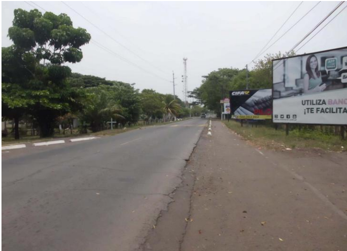
CARRETERA HACIA IZTAPA
